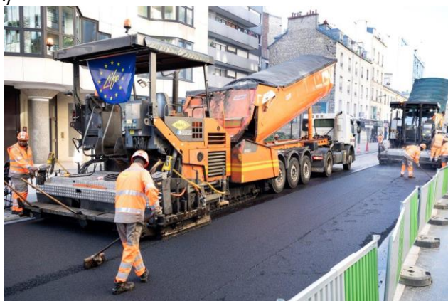
Pose du nouveau revêtement BBphon+ ® de la société Colas, rue Frémicourt, Paris 15 ème (crédits : Colas – Joachim Bertrand)
